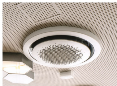
Montáž v podhledu
